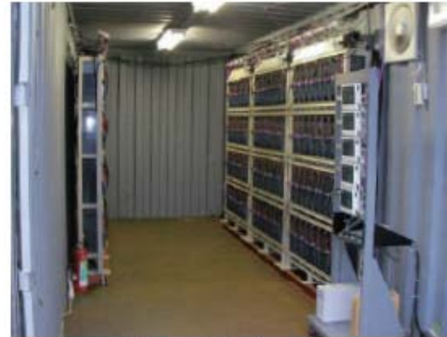
図3 蓄電池群 Fig.3 String of Batteries
